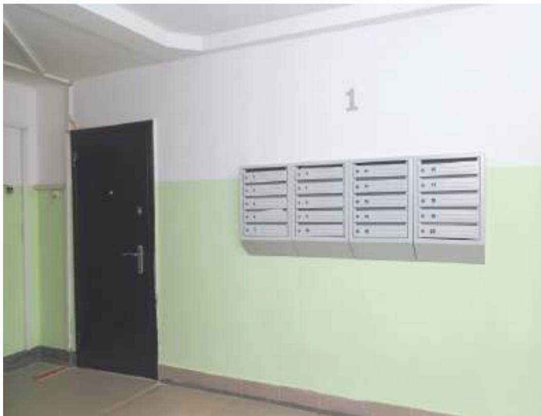
Отремонтированный подъезд в доме № 8 по Ярославскому шоссе
