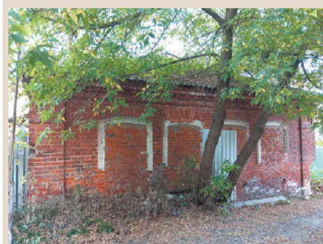
В этом здании в 1926 году находился склад игрушек Школы кустарного ученичества
