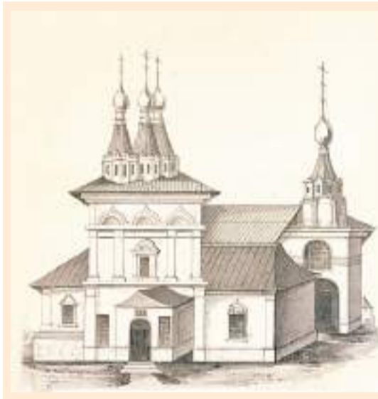
Каменная Покровская церковь, построенная в 1648 году. До наших дней она не сохранилась
